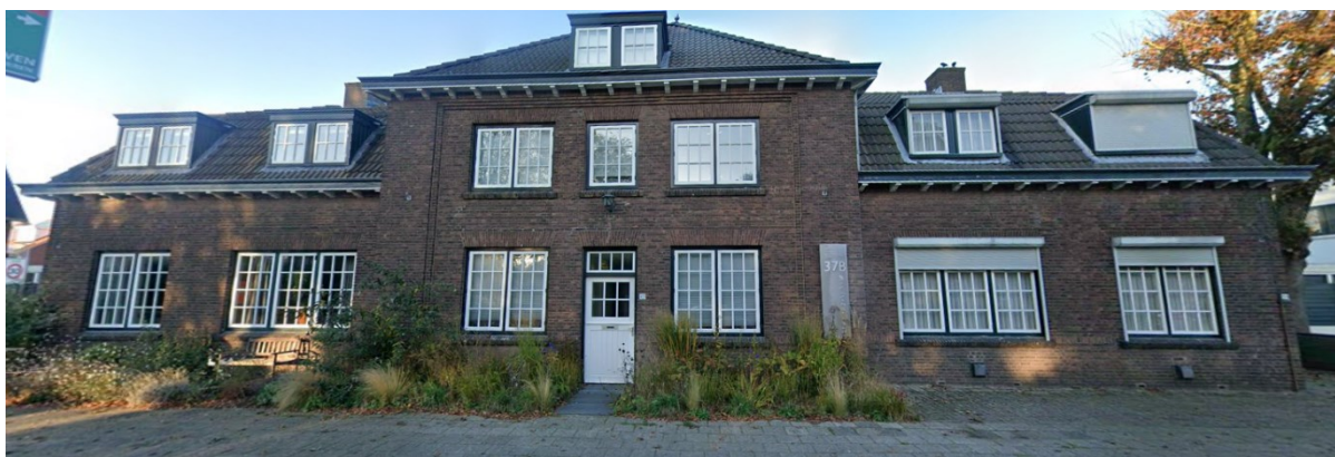
Afbeelding: Voormalige marechaussee-kazerne aan de Geldropseweg in Heeze (Google streetview 2024).
