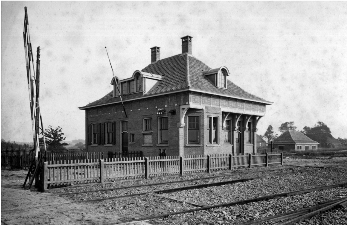
Afbeelding: Het stationgebouw van Sterksel uit 1913 (foto www.heemkundekring-hlz ).
