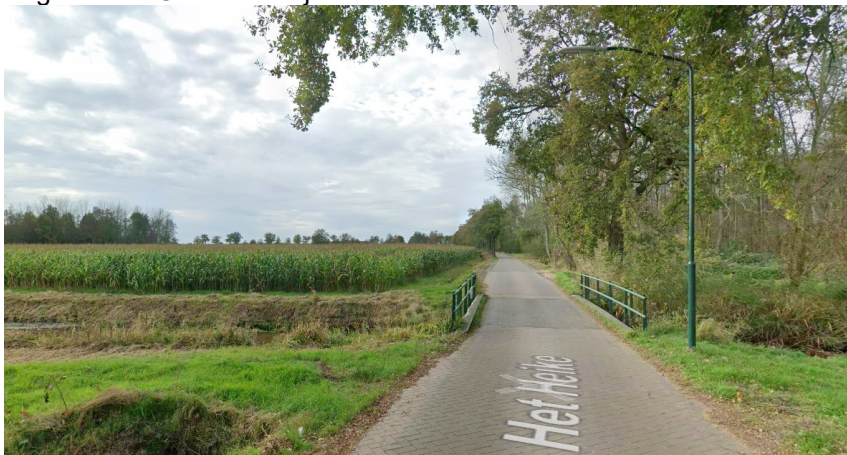
Afbeelding: De brug bij Het Heike over de Groote of Leender Aa (Google streetview 2024).
