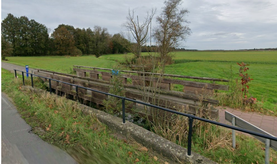
Afbeelding: De Schillemansbrug over de Sterkelse Aa bij de Heezerweg (Google streetview 2024).
