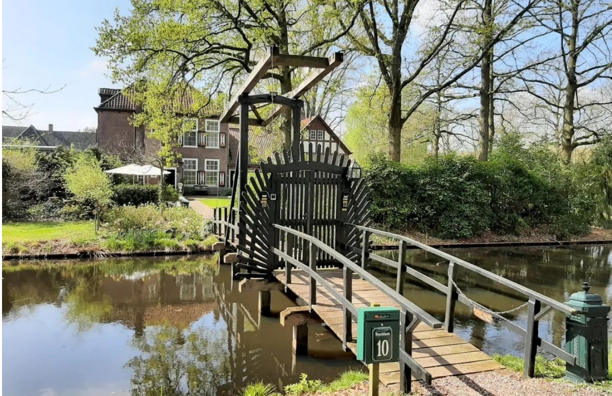
Afbeelding: De houten ophaalbrug bij Boschlaan 10 (foto Google streetview 2024).
