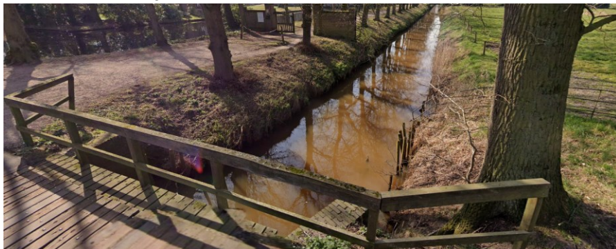
Afbeelding: Eén van de sluisjes bij Kasteel Heeze (Google streetview 2022).
