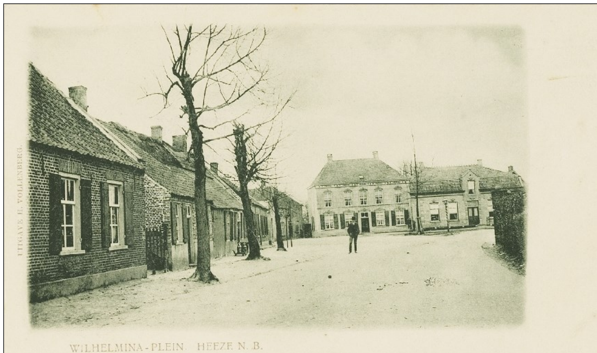
Wilhelminaplein te Heeze. 75
