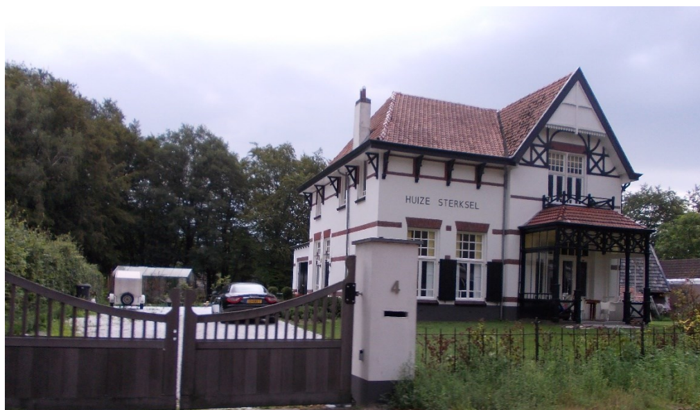
Afbeelding: Villa Pastoor Thijssenlaan 4 (augustus 2011)
