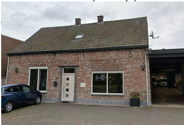
Afbeelding: Pastoor Thijssenlaan 30 in Sterksel (Google streetview 2024).
