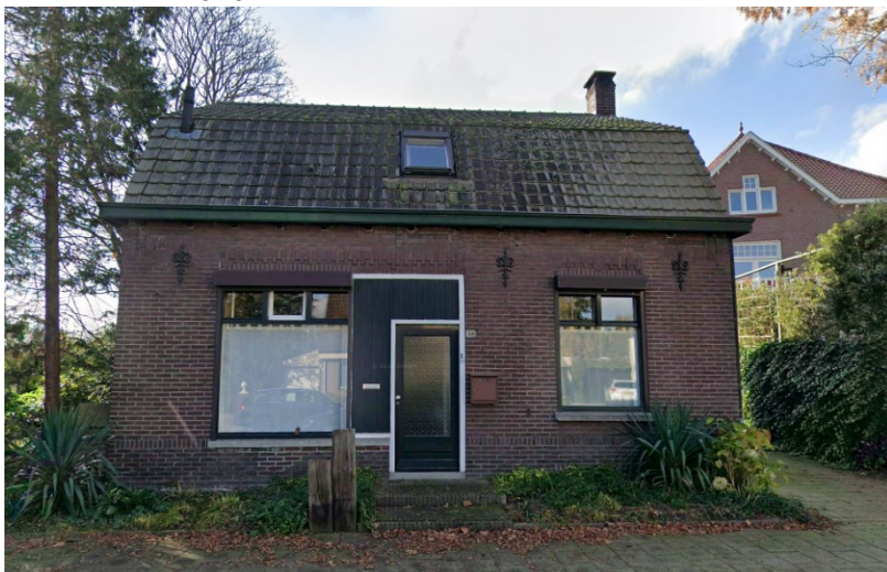
Afbeelding: Nieuwendijk 30 in Heeze (Google streetview 2023).
