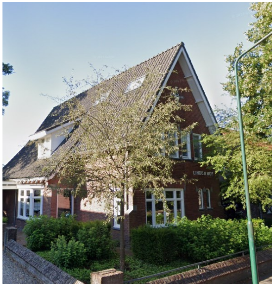
Afbeelding: Woonhuis St. Nicasiussstraat 31 Heeze (Google streetview 2025).
