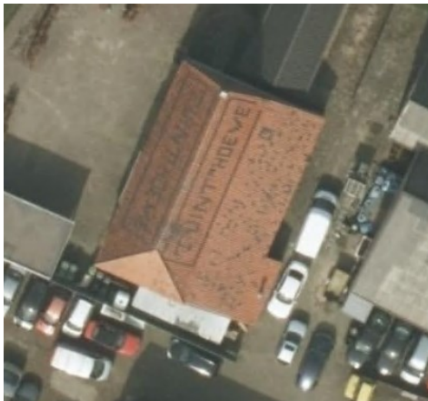
Afbeelding: Dak van schuur bij Renhoek 22 in Leende (Google maps 2025).
