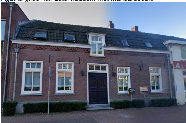
Afbeelding: Kapelstraat 104 in Heeze (Google streetview 2024).
