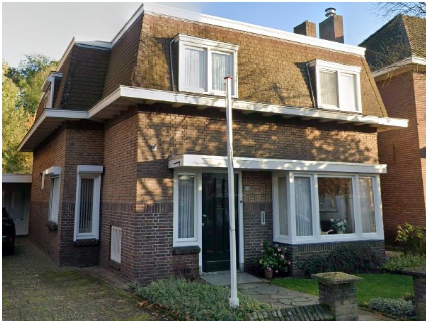
Afbeelding: woonhuis Kapelstraat 55 (Google streetview 2024).
