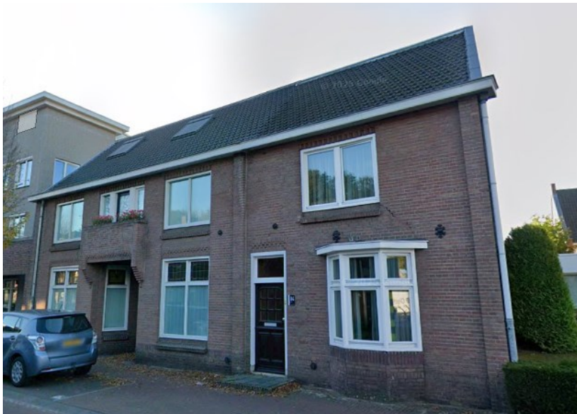
Afbeelding: Kapelstraat 84-86 in Heeze (Google streetview 2024).
