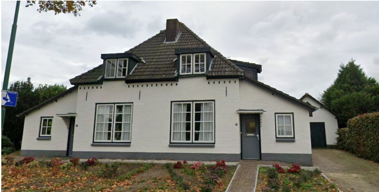
Afbeelding: Pastoor Thijssenlaan 32-34 in Sterksel (Google streetview 2024).
