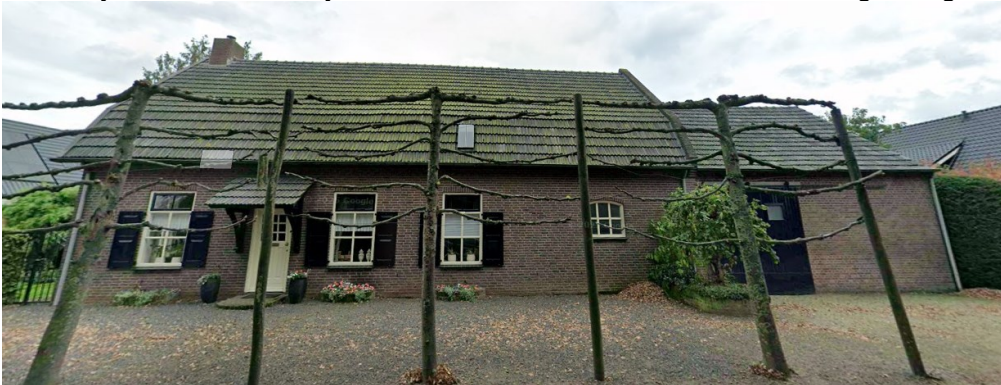
Afbeelding: Pastoor Thijssenlaan 58 in Sterksel (Google streetview 2024).
