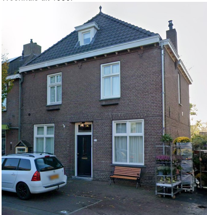
Afbeelding: Kapelstraat 22 in Heeze (Google streetview 2024).
