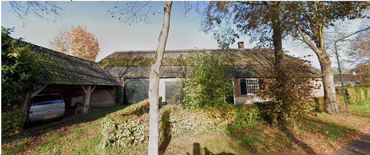
Afbeelding: Schob bij Strijperstraat 42 (Google streetview 2024).
