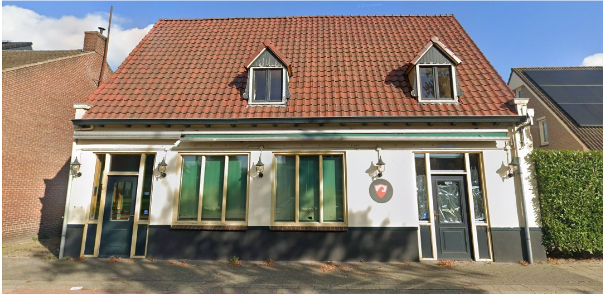
Afbeelding: Nieuwendijk 17 in Heeze (Google streetview 2024).
