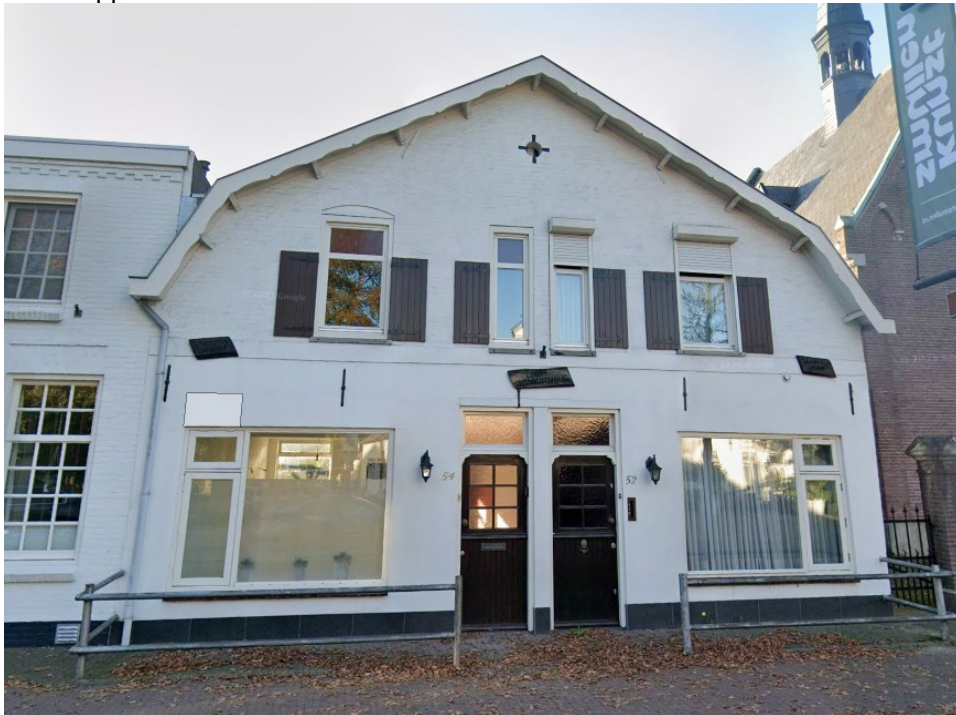
Afbeelding: Kapelstraat 52-54 in Heeze (Google streetview 2024).
