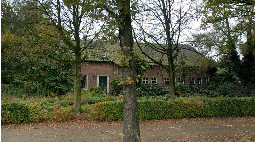
Afbeelding: Pastoor Thijssenlaan 31-33 in Sterksel (Google streetview 2024).
