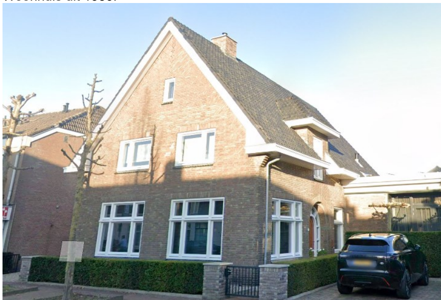
Afbeelding: woonhuis Kapelstraat 15 (Google streetview 2024).
