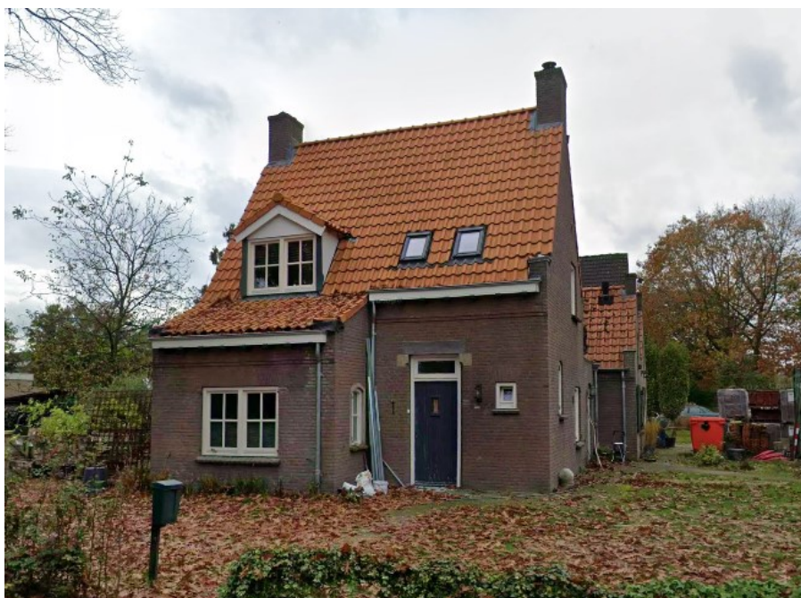
Afbeelding: Pastoor Thijssenlaan 11 in Sterksel (Google streetview 2024).
