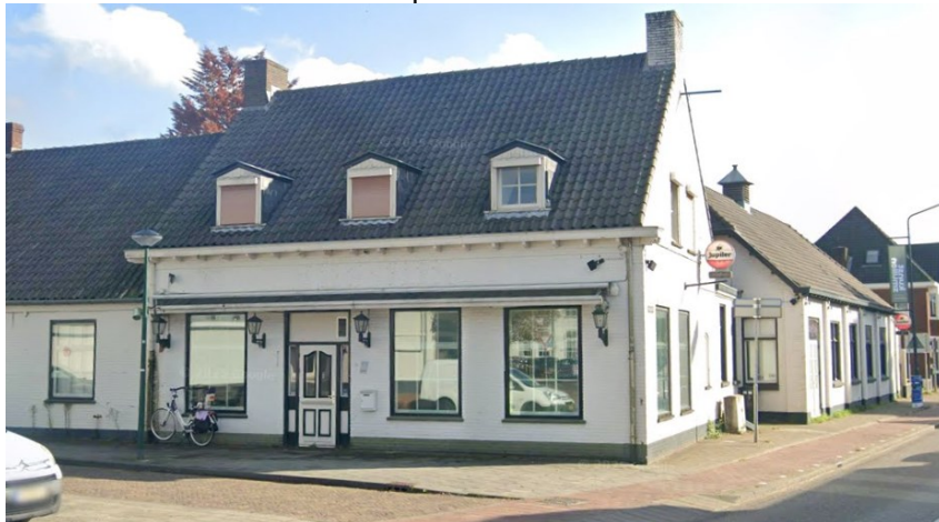
Afbeelding: Nieuwendijk 5 in Heeze (Google streetview 2024).
