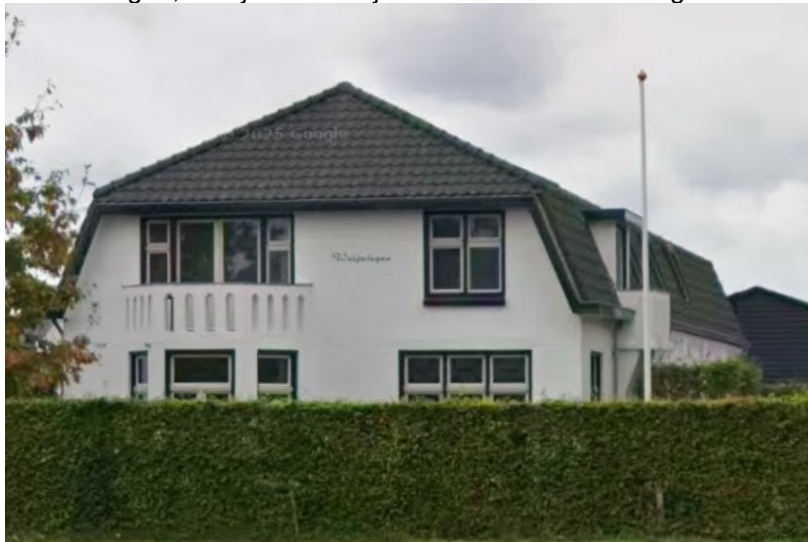
Afbeelding: Pastoor Thijssenlaan 29 in Sterksel (Google streetview 2024).
