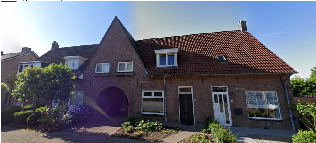
Afbeelding: De woningen aan de Schoolstraat 37-43 in Heeze (Google streetview 2023).
