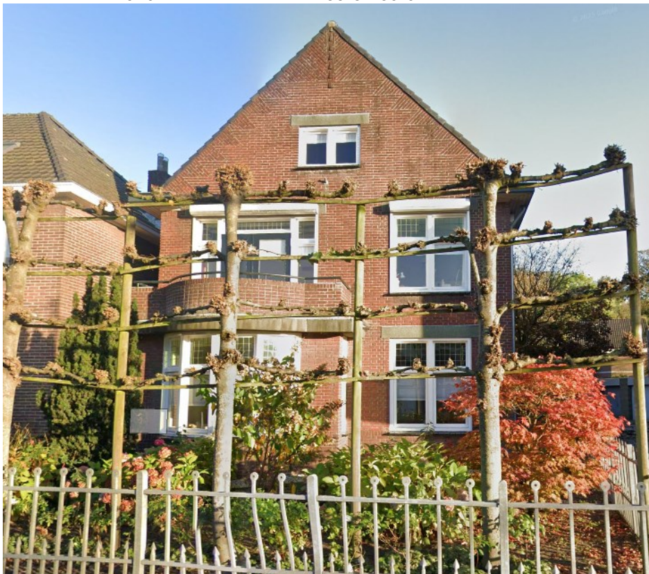
Afbeelding: woonhuis Kapelstraat 61 (Google streetview 2024).
