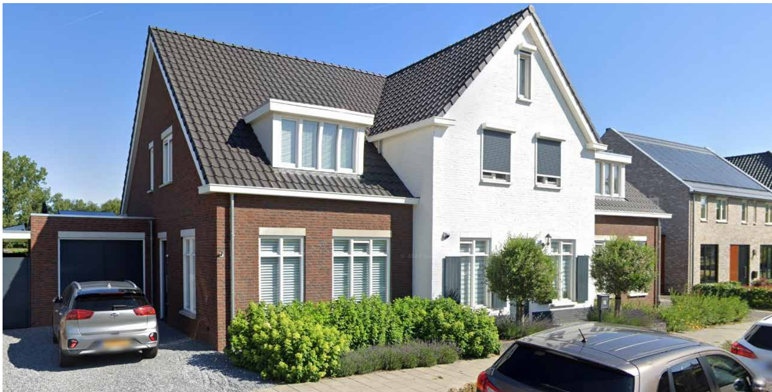
Kleurstelling bruinrode en lichte gevelstenen bij bestaande nieuwbouw aan de Breedvennen in Leende
