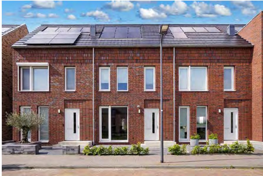
Gemetzelde details in gevel, vlakke pannen
